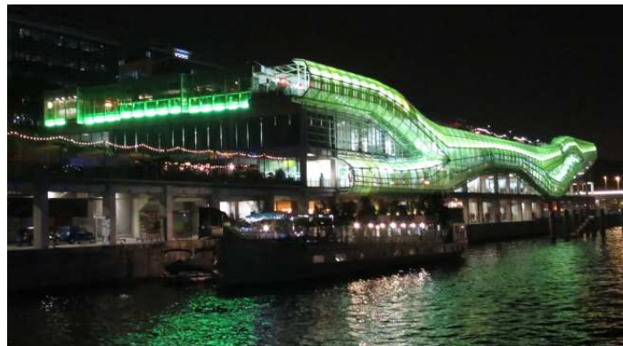
Paris, Les Docks, Quai d'Austerlitz (2017)
